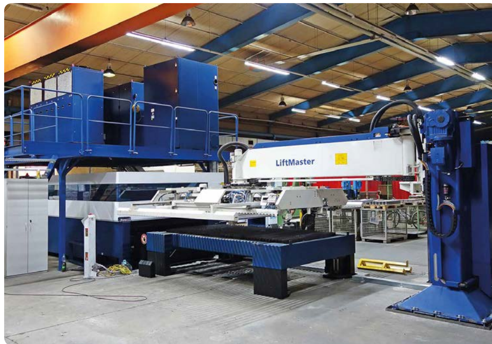
Metallbau Nick GmbH, Lampertheim
